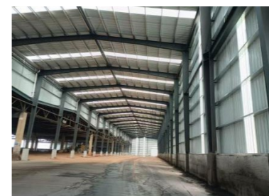
安砂建福原料堆场密闭
