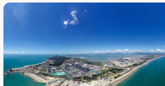
中沙古雷乙烯项目
